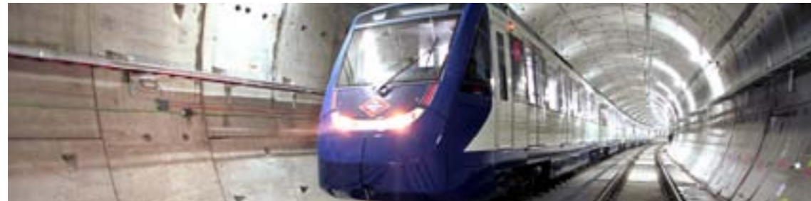
El nuevo diseño de horarios nocturnos permite aprovechar la energía que generan los trenes en los frenados para los arranques de otros.
