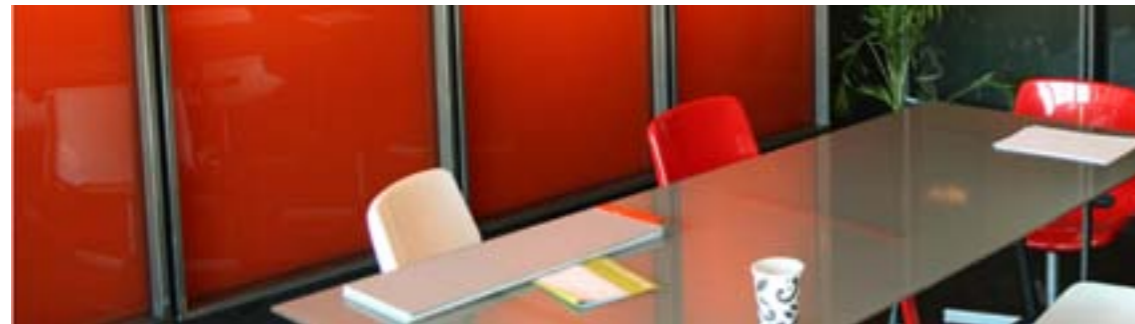
Sala de reuniones de la propia empresa spin-off, Intelliglass S.L., totalmente equipada con los acristalamientos activos desarrollados para la climatización y control de la carga solar.
